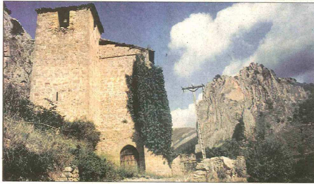
Fachada occidental, con la torre y la puerta. A la izquierda y a la derecha, la enorme roca crestada rota por el río Najerilla. Abajo, puente del XVIII, que une Las Cuevas y Anguiano
