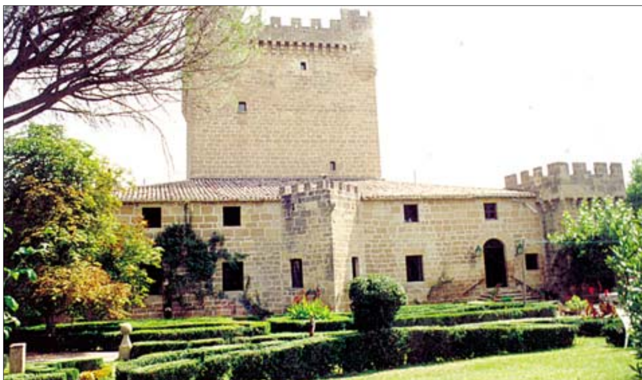
Fachada este, con cubo redondo oculto por los árboles, espolón central, cubo cuadrado a la derecha y la torre homenaje. Vista sureste, con el esquinazo cuadrado
