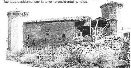
Vista de las fachadas norte y oeste. En primer plano la torre que se derrumbó parcialmente y que fue reconstruida. A continuación se aprecia en el muro el desprendimiento del haz exterior del muro preludiando el hundimiento de la torre de la derecha. Abajo, fachada occidental con la torre noroccidental hundida.
