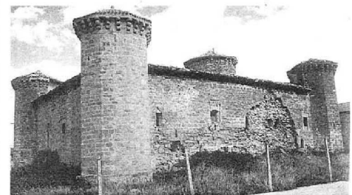
Vista de las fachadas norte y oeste. En primer plano la torre que se derrumbó parcialmente y que fue reconstruida. A continuación se aprecia en el muro el desprendimiento del haz exterior del muro preludiando el hundimiento de la torre de la derecha. Abajo, fachada occidental con la torre noroccidental hundida.
