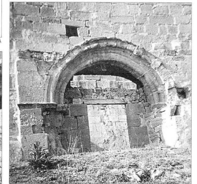
Puerta de la Iglesia de Santiago en Sajuela y detalle de la misma
