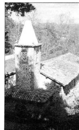
Vista exterior de la ermita de San Mamés en el Rasillo.
