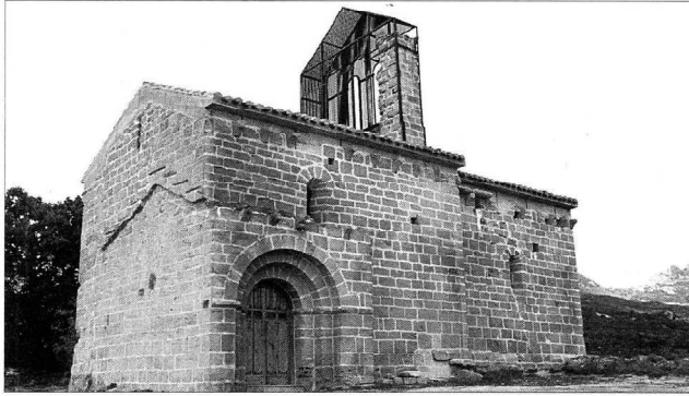
Fachada sur de la actual ermita de San Felices. La espadaña románica de dos huecos está dibujada mediante una estructura metálica
