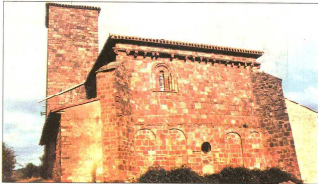
Fachada occidental, con la puerta central de herradura, que está cegada, y las cuatro arquerías ciegas. En el cuerpo superior, la ventana decorada
